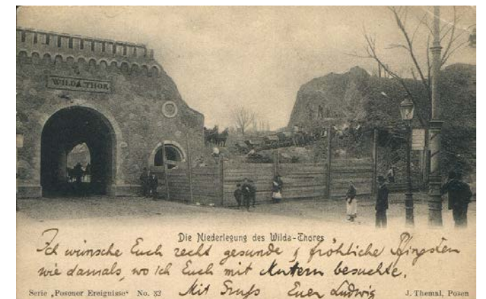
Rozbiórka Bramy Wildeckiej.
