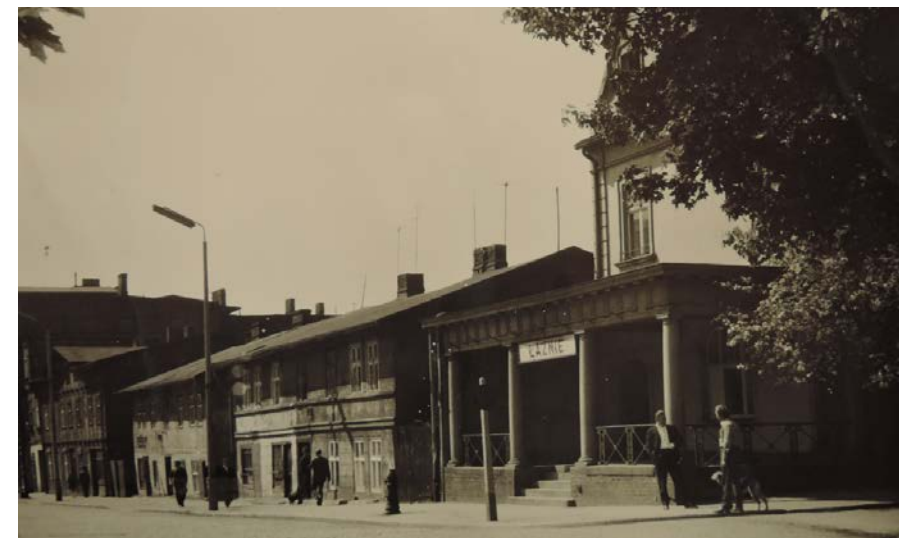
Ulica Przemysłowa widziana w kierunku południowym, na pierwszym planie budynek łaźni.
